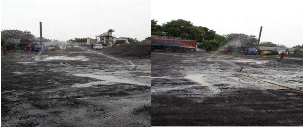
(D) Photo showing fix water sprinklers
